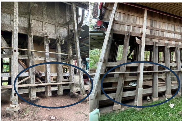
Gambar 2. Pondasi umpak dan tiang kolom utama
