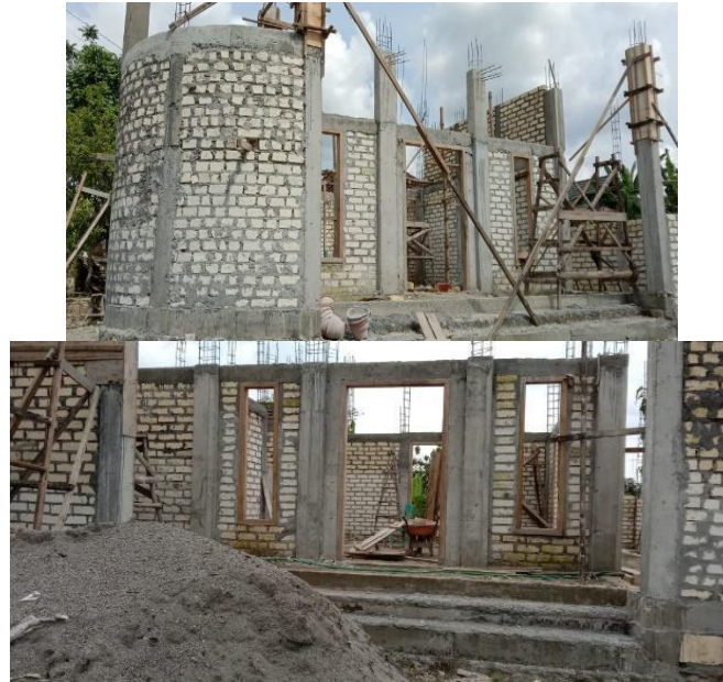
Gambar 17. Pemasangan Dinding
