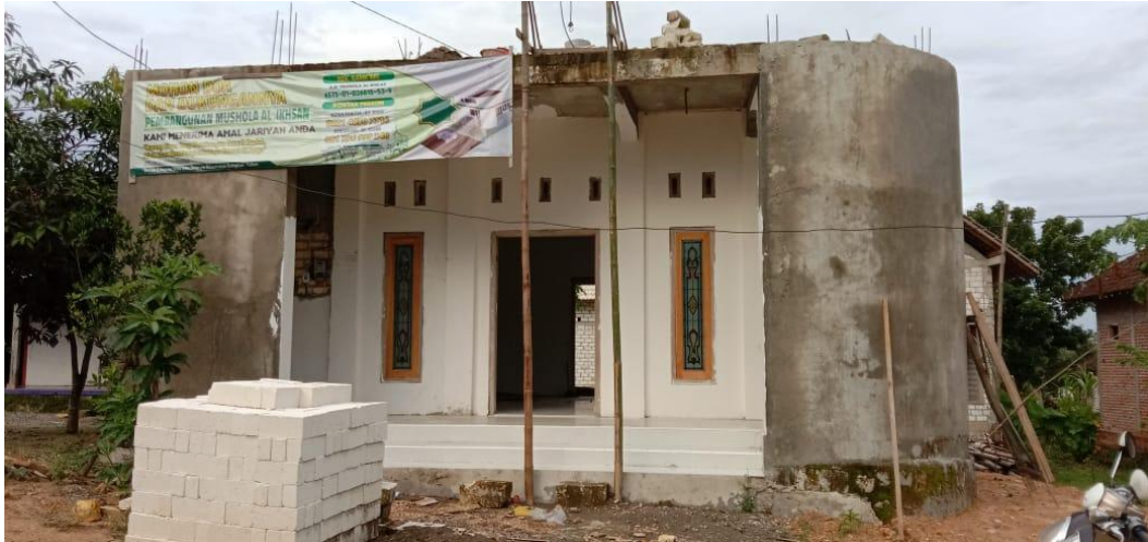
Gambar 21. Progress Pembangunan Mushola Al Ikhsan sampai Bulan September 2022
