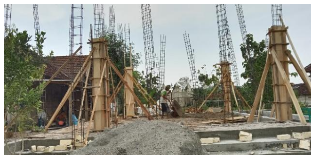
Gambar 16. Pengecoran Kolom
