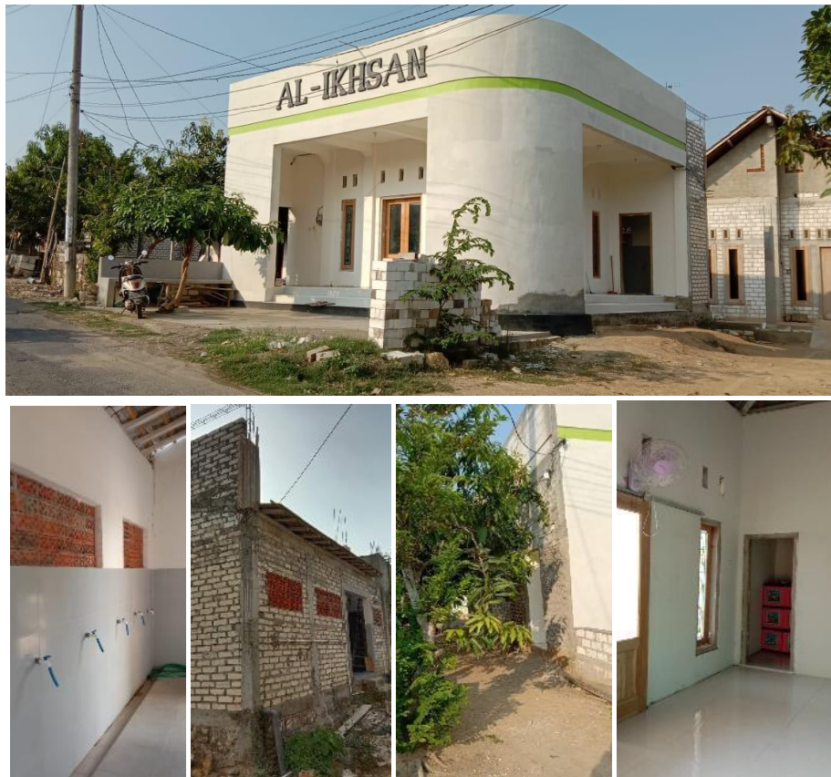
Gambar 22. Progress Pembangunan Mushola Al Ikhsan sampai Bulan November 2023
