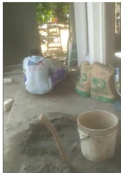
Gambar 20. Pemasangan Lantai Teras
