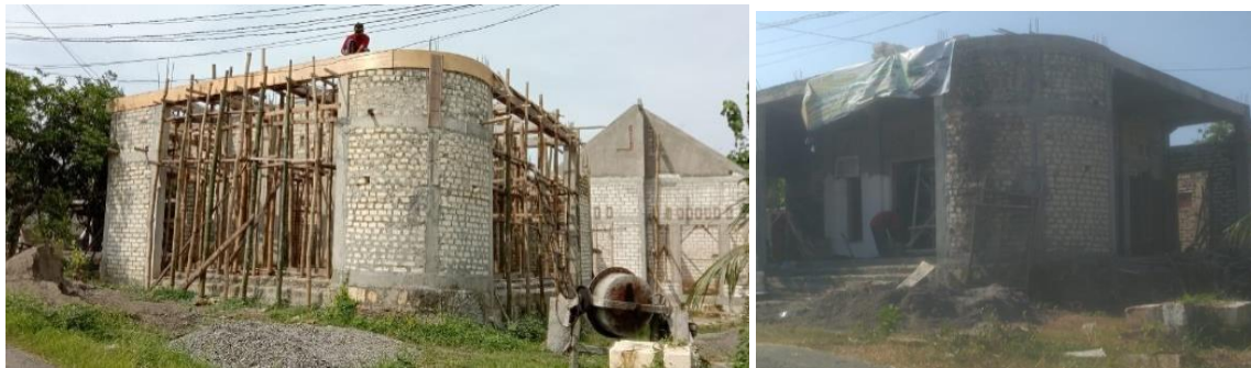
Gambar 18. Pengecoran Plat Atap
