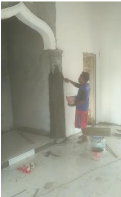
Gambar 19. Pengacian Dinding
