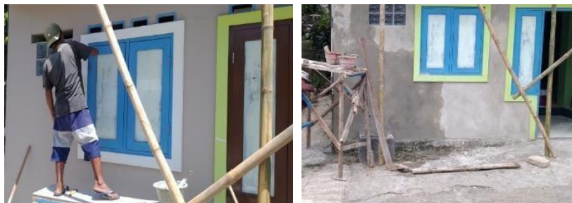
Gambar 10. Pekerjaan pengacian dan pengecatan eksterior
