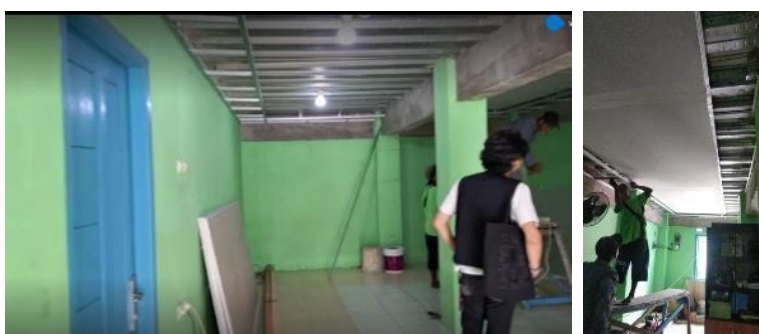
Gambar 7. Proses pekerjaan penutup plafon
